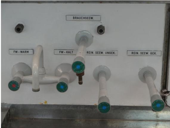
Wasserhähne für verschiedene Typen von Wasser im Nasslabor
